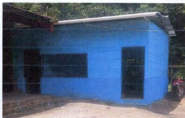
Foto 3: culminación del mejoramiento tipo pórtico.
