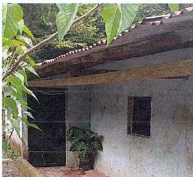
Foto 1: finalización mantenimiento de ventanas para la escuela.
