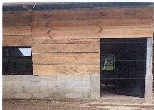
Foto 4: culminación de la instalación de puertas y Ventanas de mejoramiento tipo pórtico.
