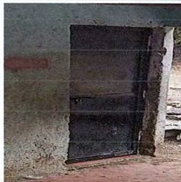
Foto 4: finalización mantenimiento de puertas para la escuela.
