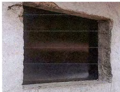
Foto 2: finalización mantenimiento de ventanas para la escuela.
