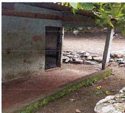
Foto 3: finalización mantenimiento de puertas para la escuela.
