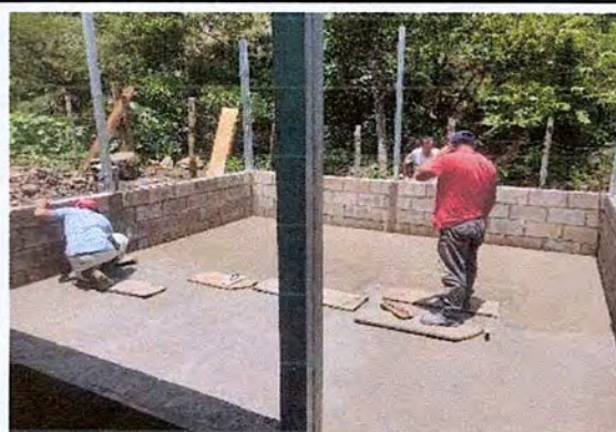
Foto 2: finalización de colocación de losa de piso torta del mejoramiento tipo pórtico.
